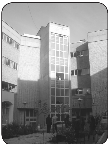
عملیات بازسازی روز چهارم پایان کار
